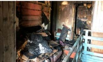
В результате пожара жилая квартира выгорела изнутри на площади 60 м<sup>2</sup>, коридор 2-го этажа поврежден на площади 20 м<sup>2</sup>.
